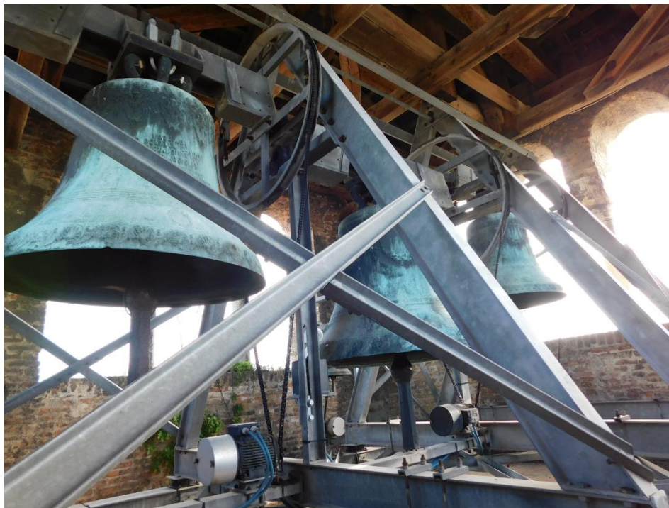
Figure 6 - A-frame bell support in San Nicolo dei Mendicoli
