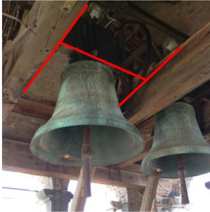
Figure 5 - H Frame in the tower of Madonna dell'Orto
