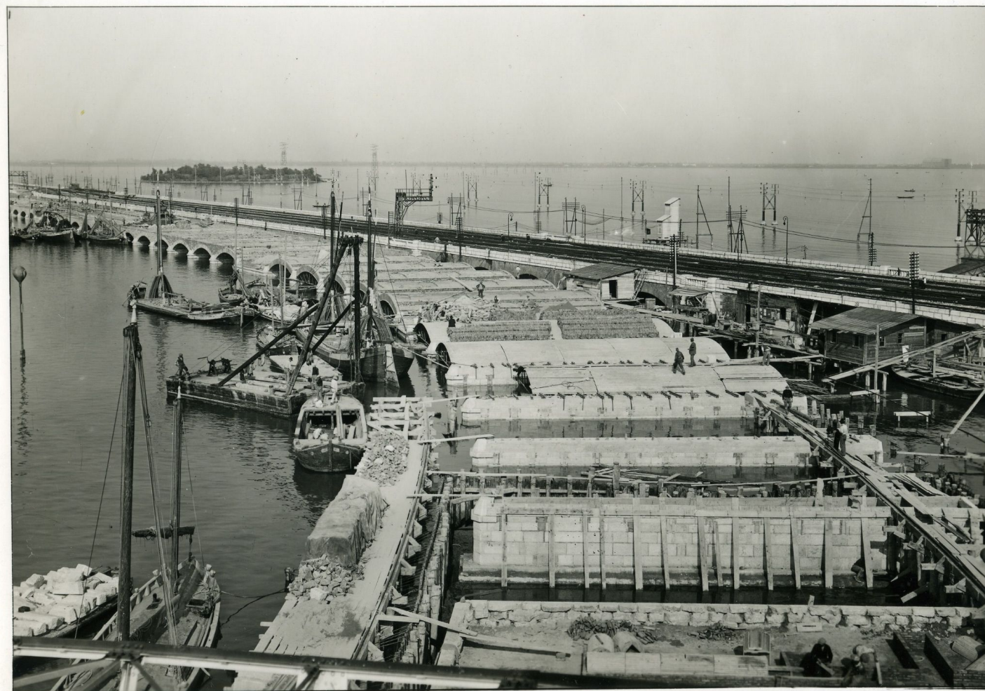
N. 49 Impresa Ingg. F. lli Scarpari - Adria — Costruendo ponte Venezia - Mestre 18 - 10 - 1932 - X Foto Ferruzzi
