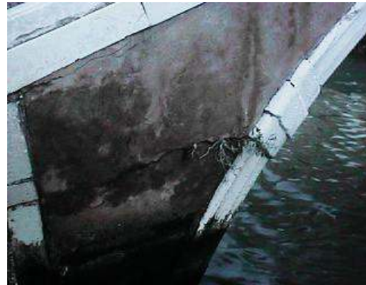
Intonacato - Red or gray plaster over brick
