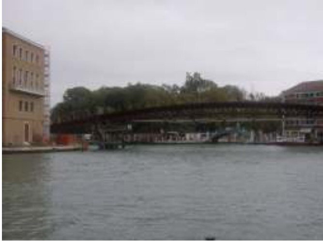
Figure 13– Ponti di Calatrava under construction
