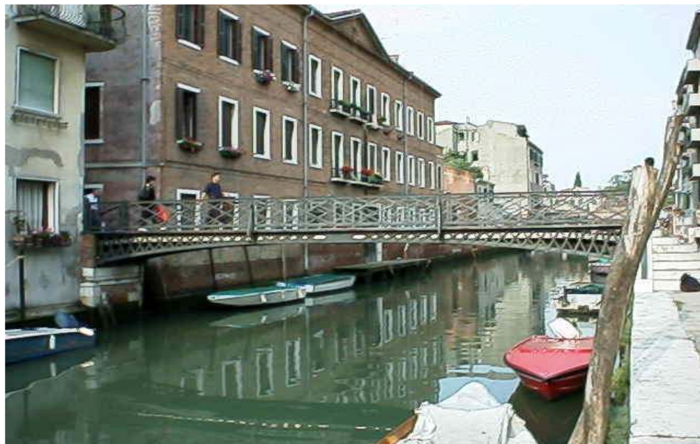
Figure 5- Ponte dei Guardiani, an example of a piatto bridge design
